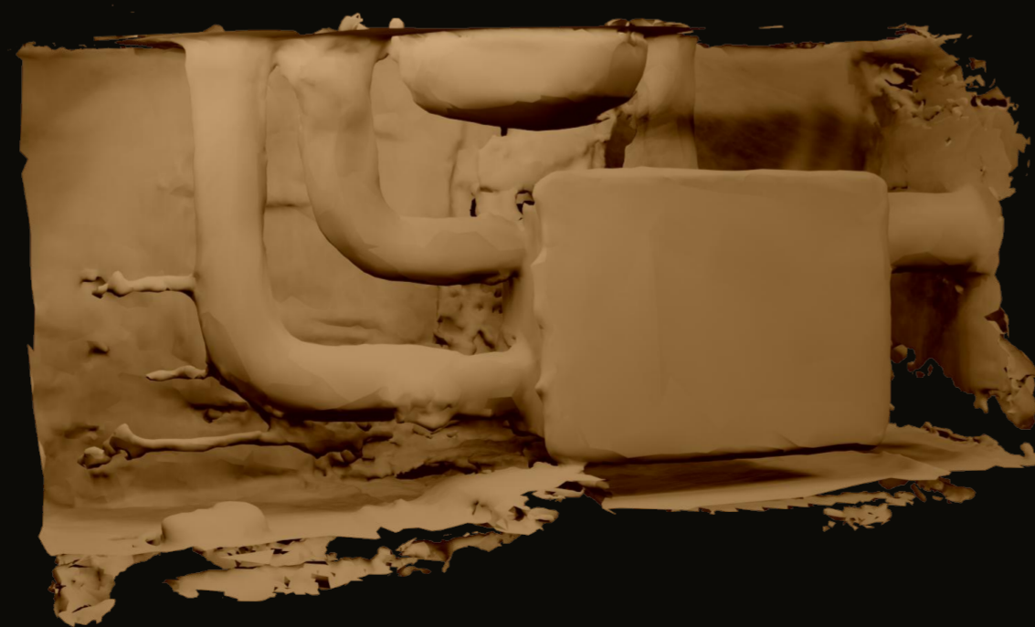
Hollow Flow Conduit
